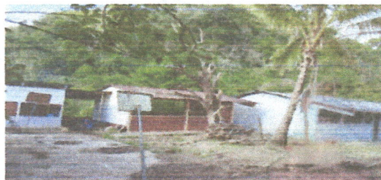
CAMBIO DE LÁMINA, AULAS CONA Y BAÑOS.
