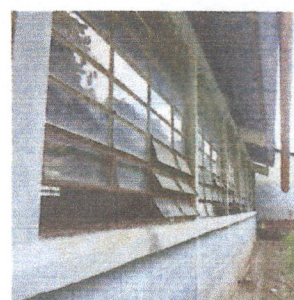
VENTANAS DE COCINA Y SUSTITUCIÓN DE VIDRIOS POR BALCONES. CON MANTENIMIENTO A ESTRUCTURA METALICA.
