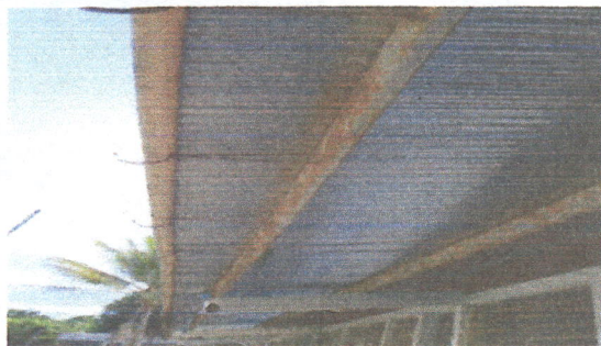
MANTENIMIENTO DE ESTRUCTURA DE TECHO.
