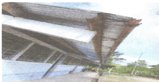
SUSTITUCIÓN DE CANALES Y BAJADAS DE AGUA PLUVIAL.
